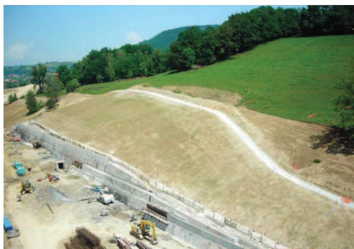
FRANCE - Cruseilles A41 (2007) Mur de soutènement de Troinex
