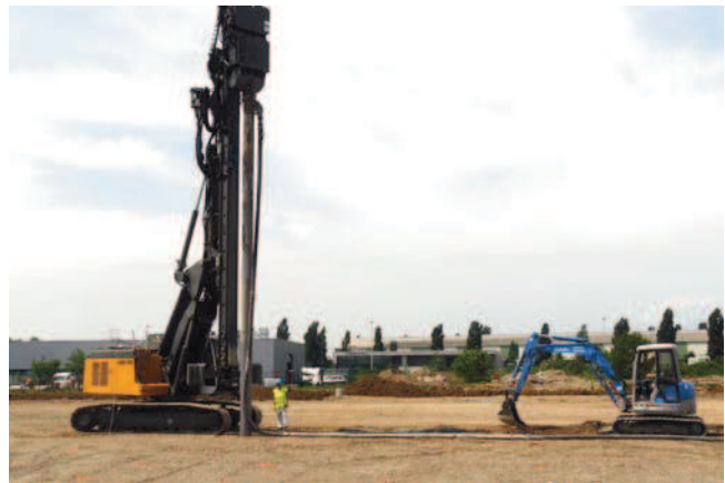
Réalisation d'inclusions rigides avec tube vibrofoncé
