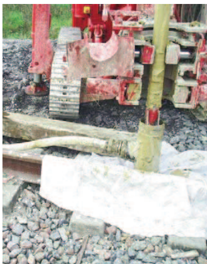
Introduction de l'outil ouvrant dans l'avant-trou tubé
