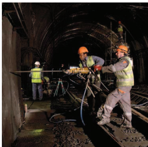
< FRANCE - Maintenance du métro Parisien Entretien des tunnels et stations en-dehors des heures de fonctionnement
