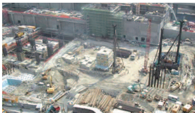
HONG KONG - 402 - Pieux H métalliques
