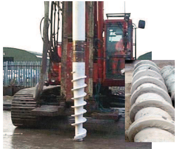
Outil SCREWSOL monté sur une foreuse
