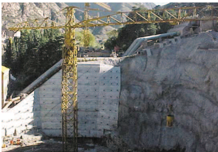
ARGENTINE - Complexe hydro-électrique de Potrerillos (2000) Soutènement du talus nord-ouest de la futur centrale de Cacheuta
