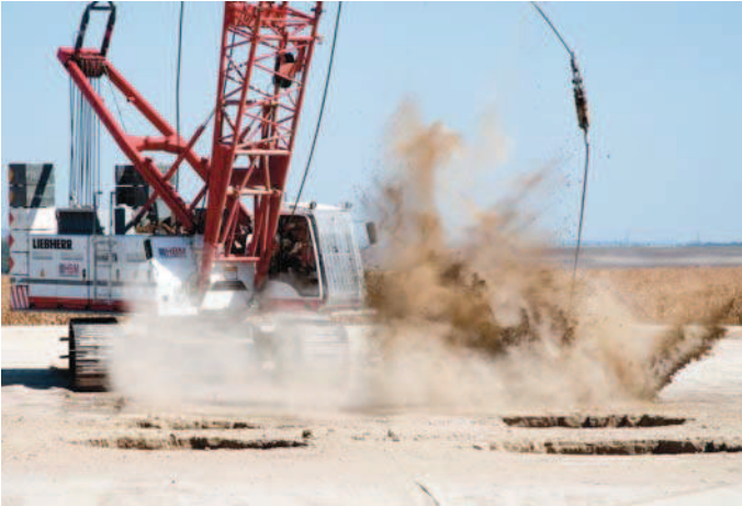
Atelier de compactage dynamique
