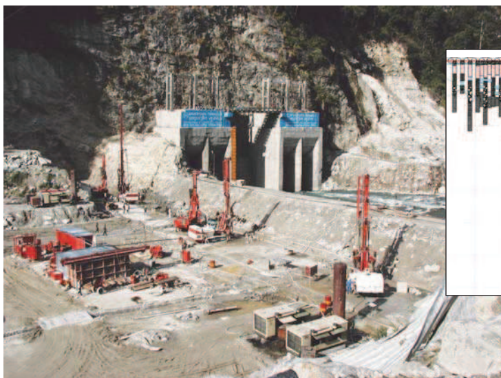
INDE - Coupure étanche du batardeau amont du barrage de Teesta
