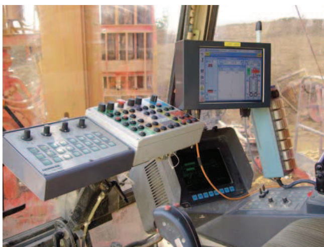
Poste de pilotage d'hydrofraise avec ENPAFRAISE
