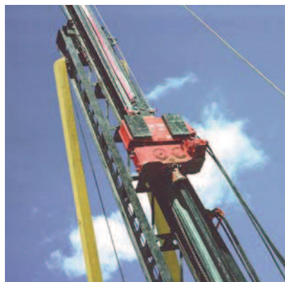
Mât de forçage du mandrin avec vibreur en tête
