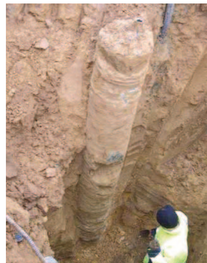
Colonne d'essai excavée
