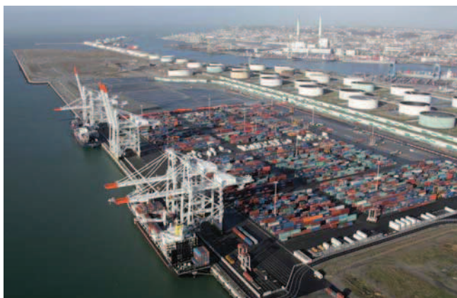
FRANCE - Le Havre - Port 2000 - 1,6 km de quai en paroi moulée
