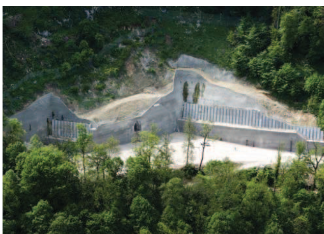
FRANCE - Besançon - Tunnel du Bois de Peu (2004) Paroi clouée
