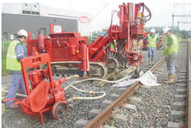
Foreuse intervenant sur les voies
