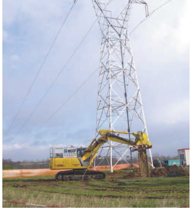
TRENCHMIX JUNIOR : application au confortement des pylônes
