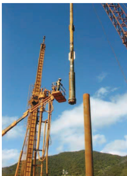
NOUVELLE CALEDONIE - Prony Pieux forés au marteau fond de trou
