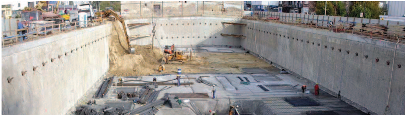
POLOGNE - Varsovie - Prosta Center - 3 600 m 2 de paroi moulée de 0,60 m d'épaisseur
