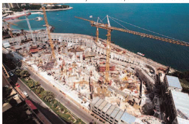
MONACO - Centre Culturel et des Expositions - Fouille de 25 m de profondeur
