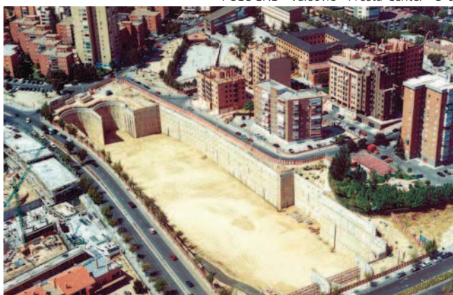
ESPAGNE - Madrid - Palacio Municipal del Hielo - 6 400 m 2 de paroi moulée
