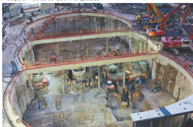
SINGAPOUR - The Sail@Marina Bay - 6 800 m 2 de paroi moulée multi-cellulaire
