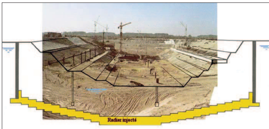
SLOVAQUIE Gabčíkovo Fond injecté dans les alluvions du Danube
