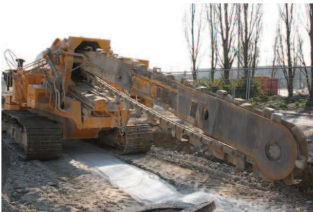
FRANCE - Montereau Plateforme de stockage (amélioration des sols par TRENCHMIX)
