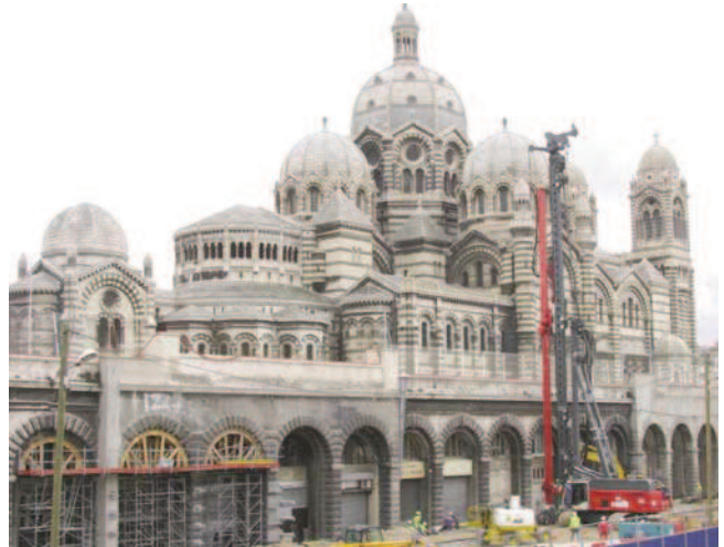
FRANCE - Marseille - Axe littoral Soutènement en paroi GEOMIX
