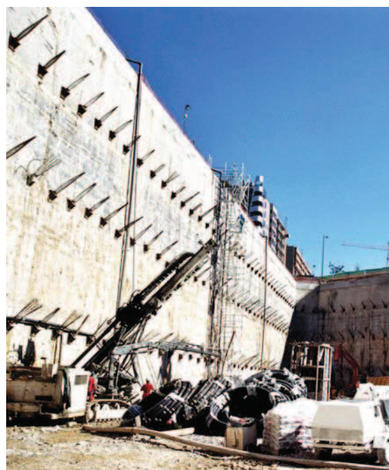
ESPAGNE - Valencia - Corte Inglés (2001) Bâtiment à usage commercial
