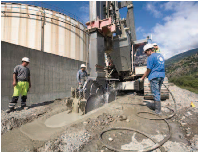
SUISSE - Viège Ecran d'étanchéité en paroi GEOMIX
