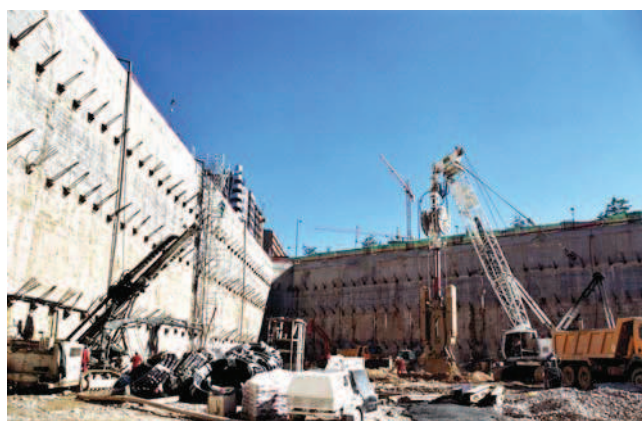
ESPAGNE - Valencia - Corte Inglés - Paroi moulée de 54 m de profondeur
