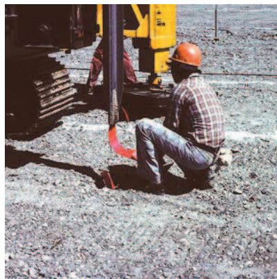
Installation du sabot d'ancrage du drain dans le sol
