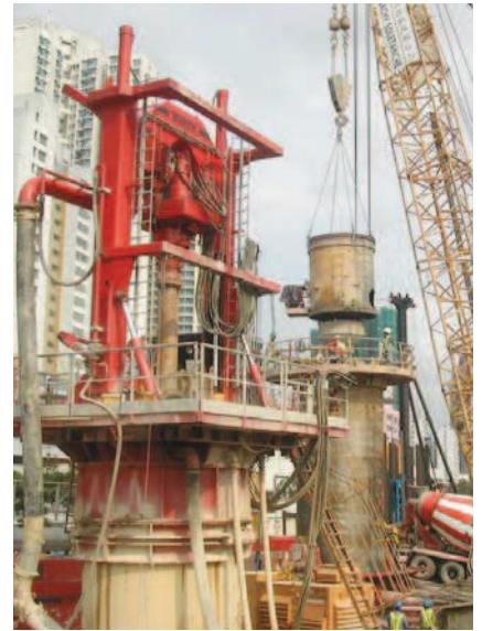
HONG KONG - 402 Machine de forage de pieux en circulation inverse
