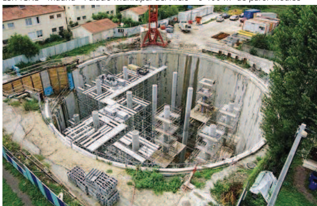
FRANCE - Floirac - Paroi moulée circulaire de 31 m de diamètre
