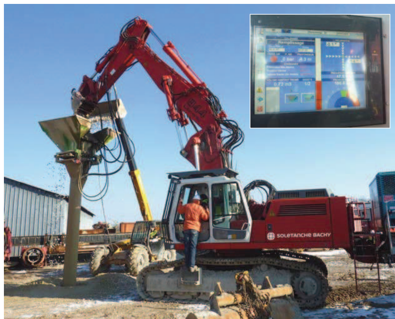
Atelier de colonnes ballastées STITCHER avec système d'enregistrement COBALT
