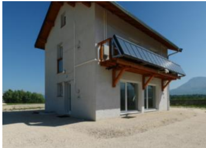
Figure 1 : vue Sud-Est de la maison INCAS "Double-Mur" (source : LISTIC – Polytech Annecy Chambéry)
